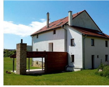
Rekonštrukcia Starého mlyna
